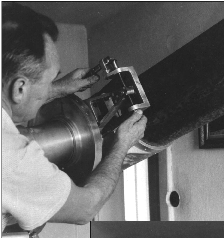
Sestavování ustanovky a jemného pohybu deklinační osy refraktoru 200/3000 mm pro LH ve Ždánicích v říjnu 1962. Optiku vybrousil prof. Ing.V.Gajdušek, autorem mechanické části je pan F.Kozelský (snímky z jeho minidílny, viz níže, též str.76).
